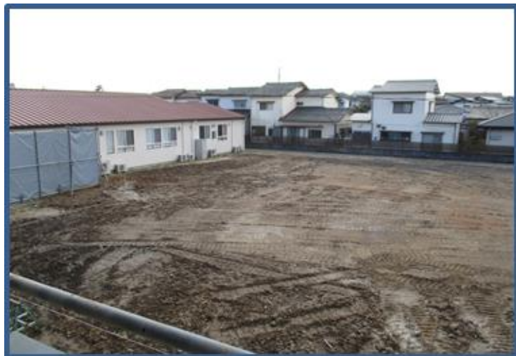
【2017年1月20現在】 旧館解体後、更地の状態でした。
