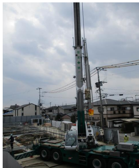
大型クレーン車の登場。写真は鉄筋搬入の様子。全長はなんと最大約44m、70t！ カメラでとらえきれないサイズでした。
