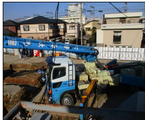
コンクリートポンプ車の登場。写真はステコンクリート打設の様子。(2/28) 敷地内全域にホースが行き届きます。
