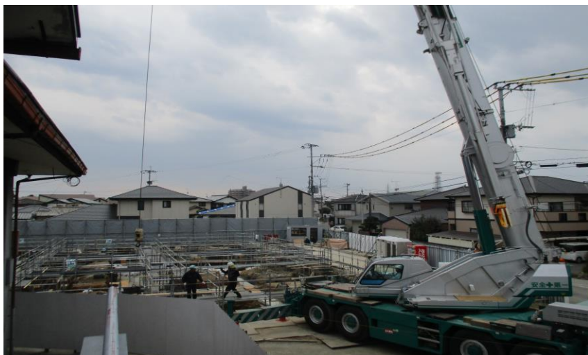
大型クレーン車の登場。写真は鉄筋搬入の様子。全長はなんと最大約44m、70t！ カメラでとらえきれないサイズでした。
