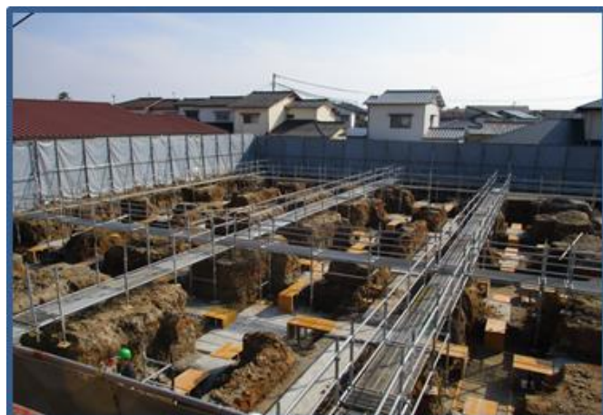
【2017年3月2現在】 鉄筋搬入・組み立てが始まりました。
