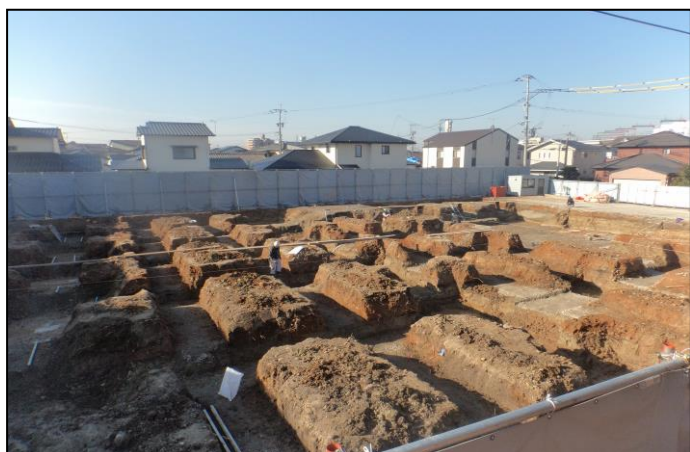
【2017年2月27現在】 床掘りが完了しました。
