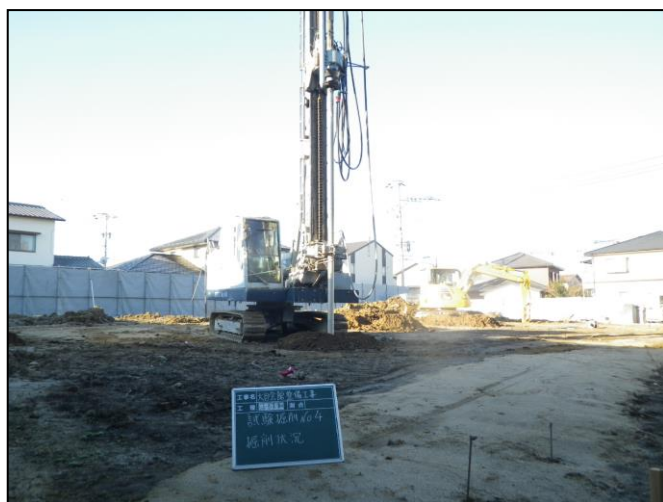
【2017年1月28現在】 建物位置確認後、杭工事に着手しました。
