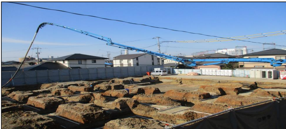
コンクリートポンプ車の登場。写真はステコンクリート打設の様子。(2/28) 敷地内全域にホースが行き届きます。
